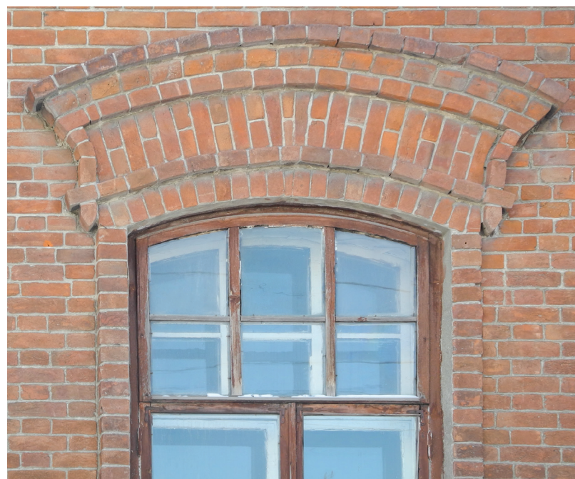
Сандрик (западный фасад)
